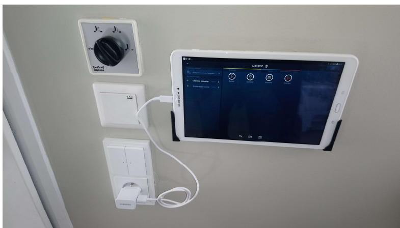
Installation des équipements domotiques dans l'appartement « Adéquat » à la résidence BLAGNY
